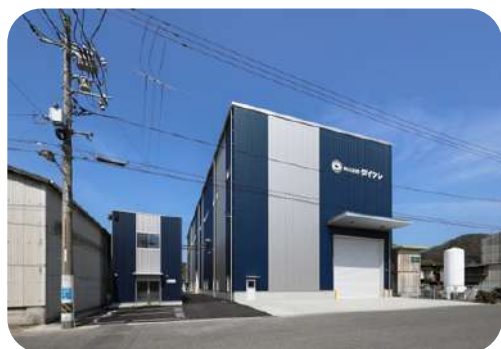
(株)ダイクレ安芸津工場 新築工事
