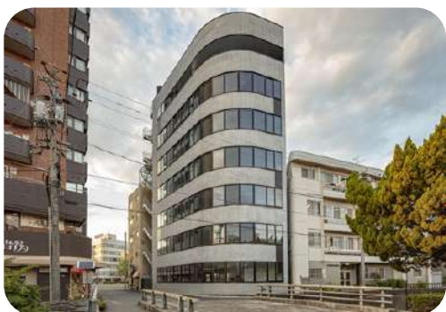
(仮称) 大矢整形外科病院新築工事
