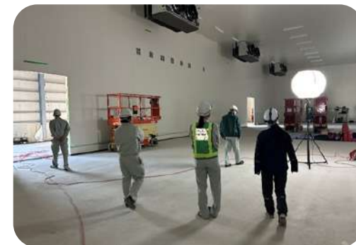
中通冷蔵(株)冷凍倉庫新築工事
