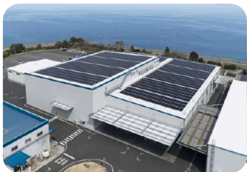
デルタ工業(株)由宇工場第3 プレス工場棟新築その他工事
